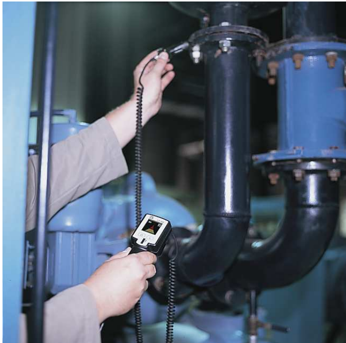
- Wykrywanie wycieków przy użyciu LD 300 -
